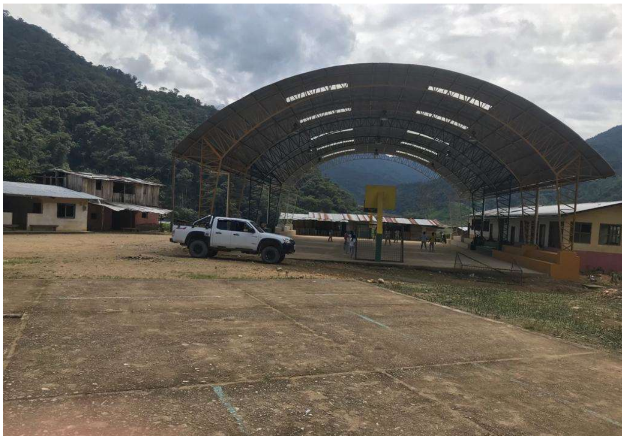
Imagen 10: Tramo de fachada del centro poblado Wankuis
