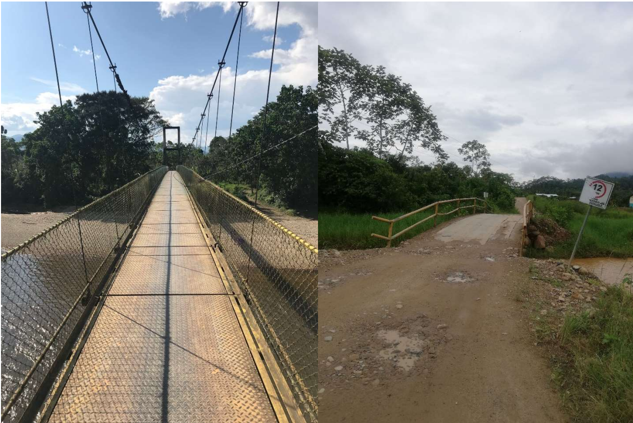
Imagen 33: Puentes de acceso hacia la parroquia Nankais Fuente: Equipo consultor PDOT 2020 Elaboración: Equipo consultor PDOT 2020
