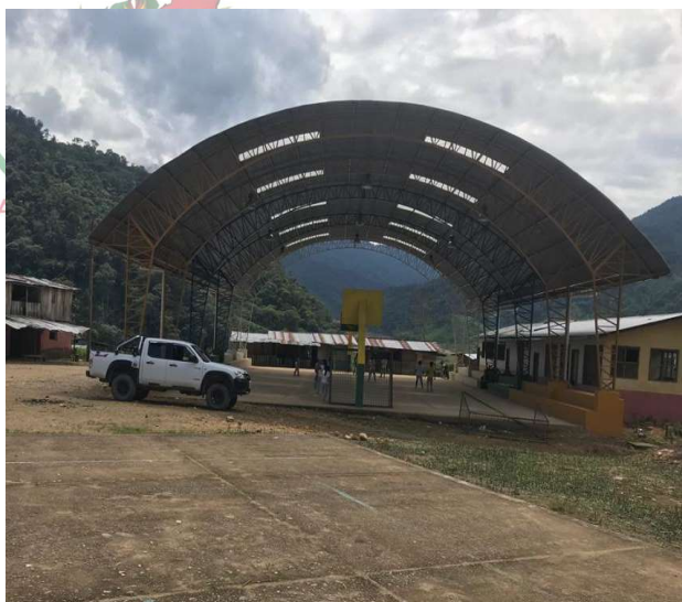
Imagen 28: Espacio cubierto Wankuis Fuente: Equipo consultor PDOT 2020 Elaboración: Equipo consultor PDOT 2020
